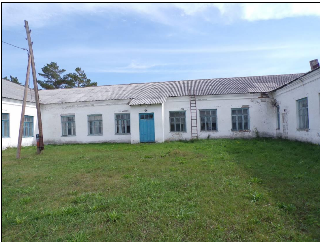
Фрагмент фасада в осях «2-3»
