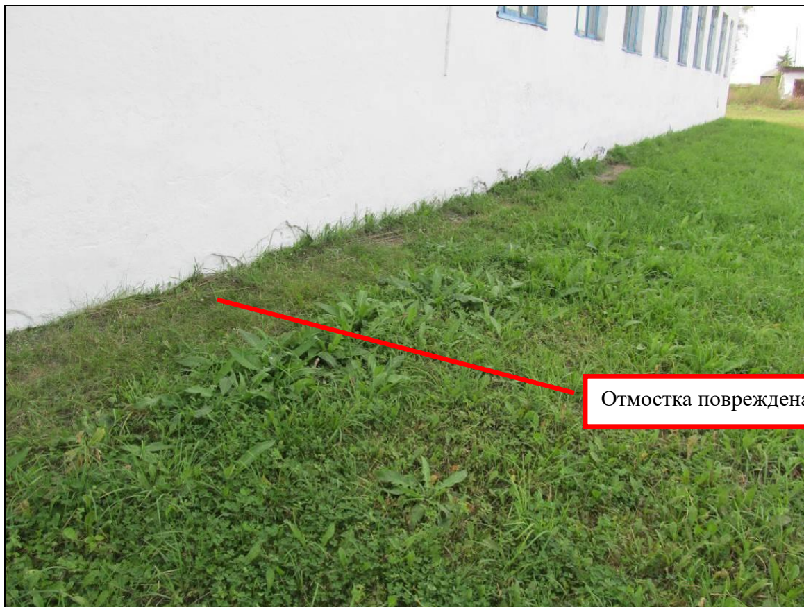
Рис. 19 Фрагмент отмостки в осях «1-4/Г»
