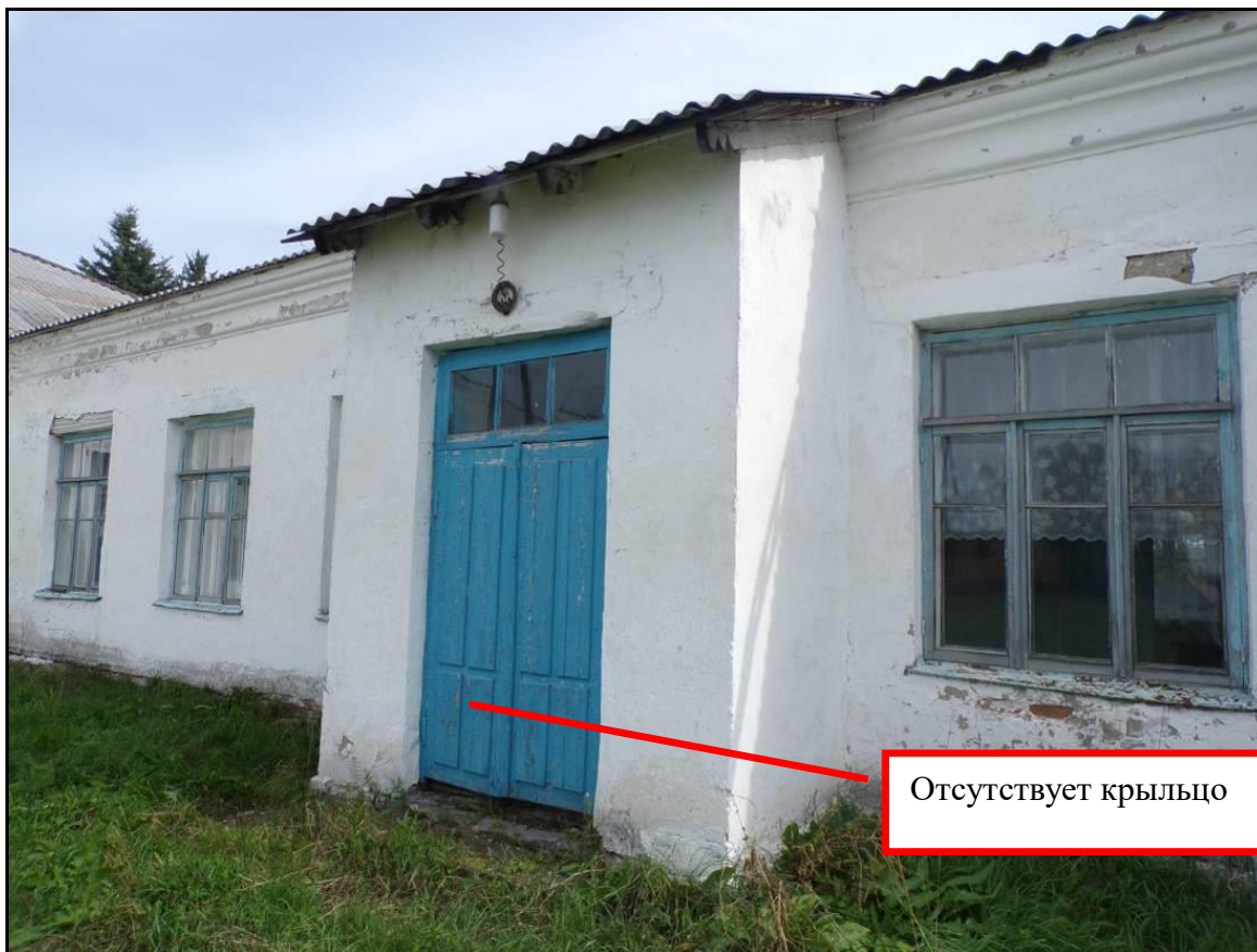
Рис. 13 Фрагмент входного узла в осях «2-3/В»
