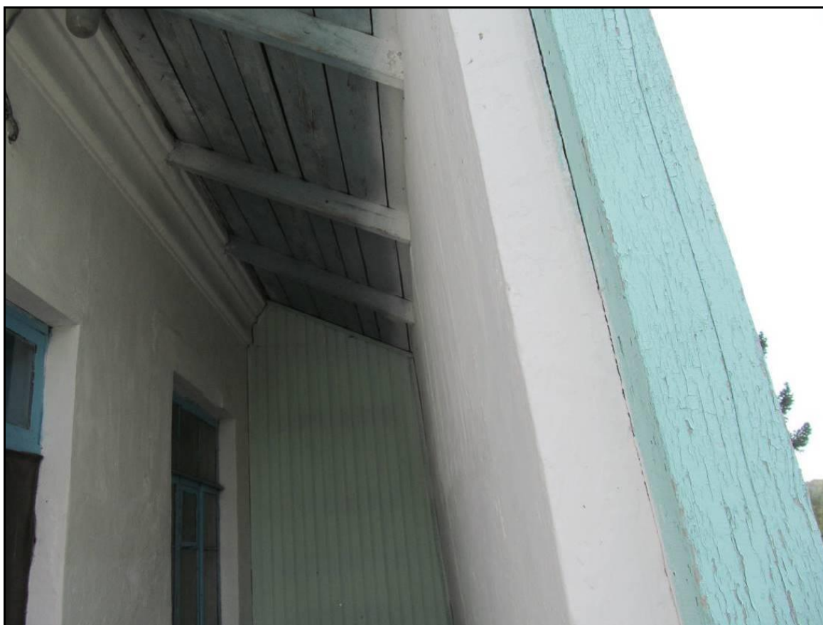
Рис. 18 Фрагмент входного узла в осях «4/Б-В»
