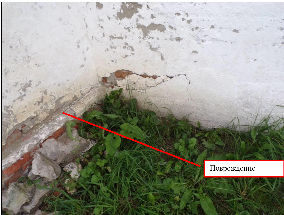
Рис. 3 Фрагмент цоколя стены
