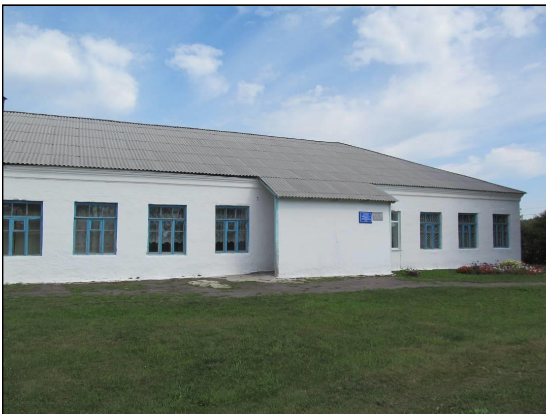
Фрагмент фасада в осях «Б-Г»
