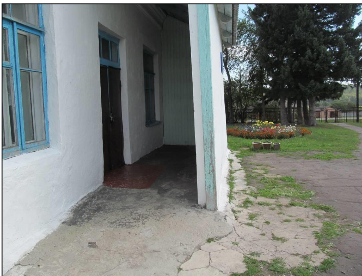
Рис. 20 Фрагмент входного узла в осях «4/Б-В»
