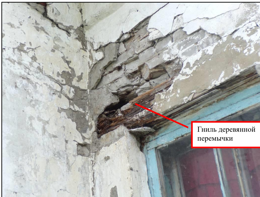
Рис. 1 Фрагмент деревянной перемычки в осях «3/В»
