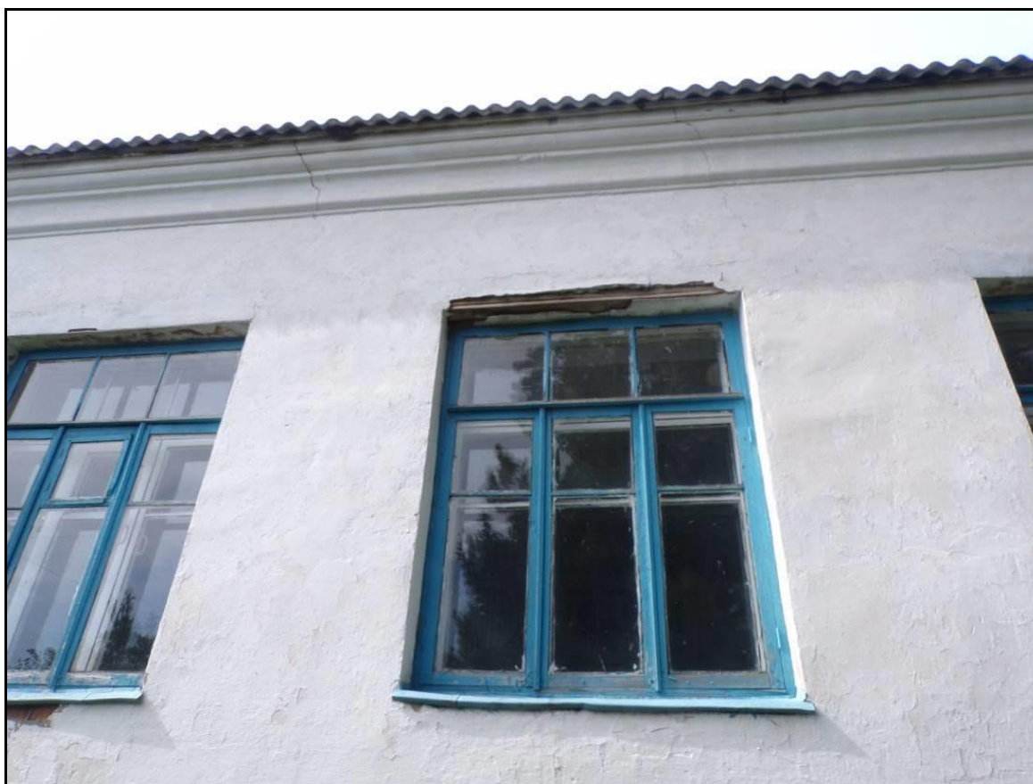
Рис. 14 Фрагмент деревянных оконных блоков в стене по оси «Г» в осях «1-2»
