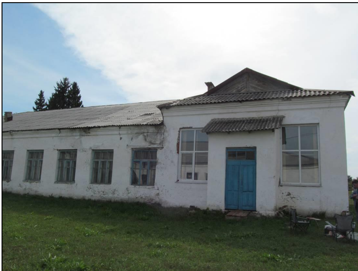
Рис. 15 Фрагмент входного узла в осях «3/А-Б»
