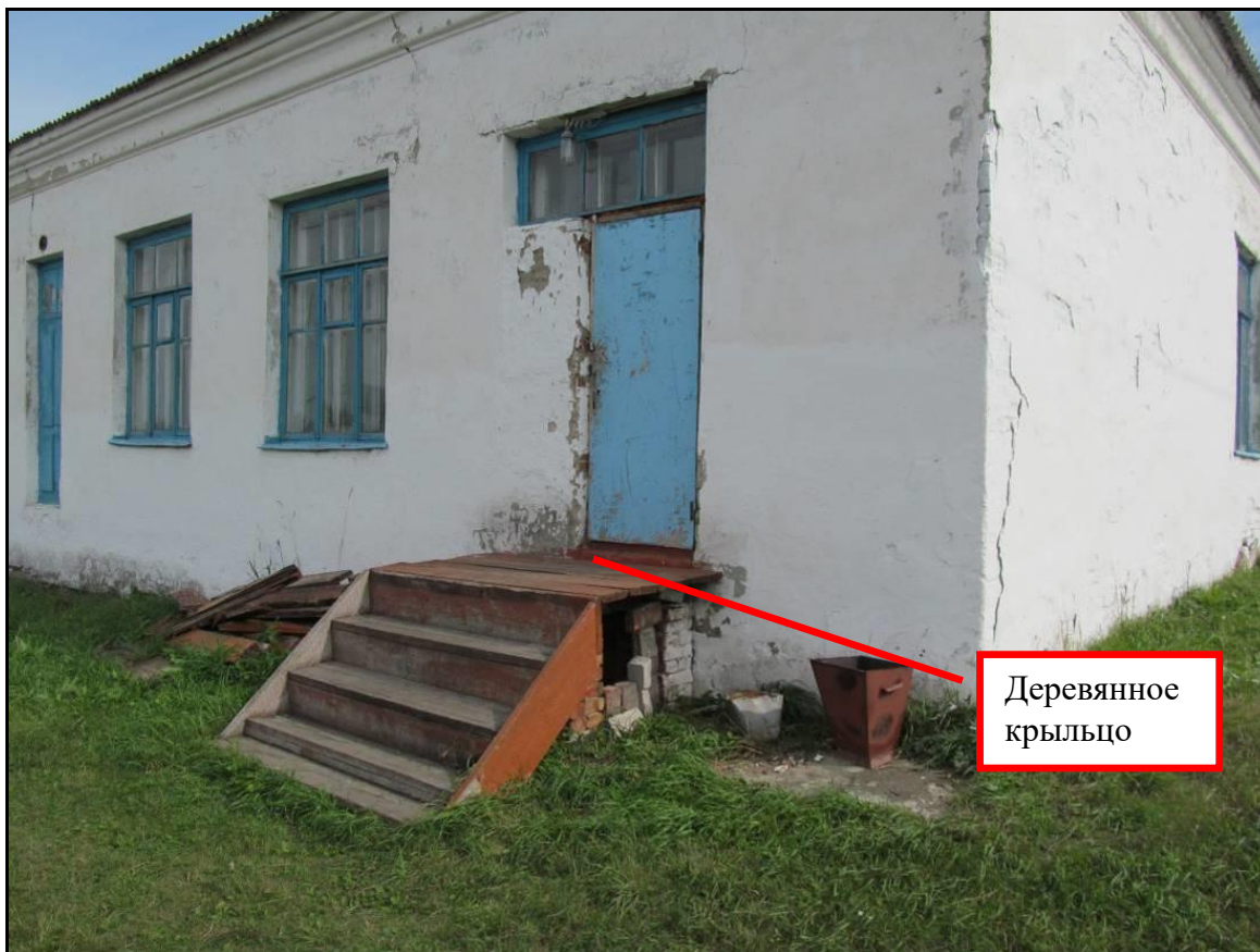
Рис. 17 Фрагмент входного узла в осях «1-2/А»
