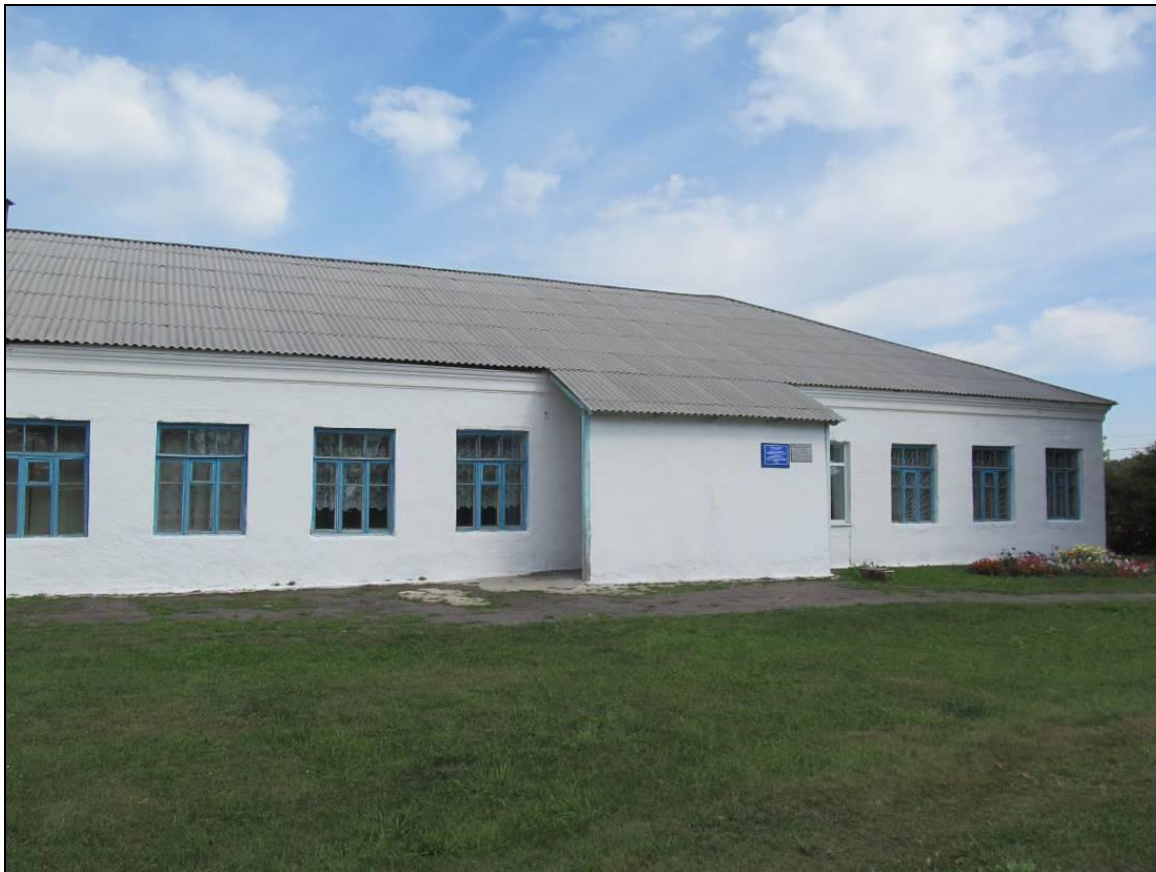
Рис. 21 Фрагмент входного узла в осях «4/Б-В»
