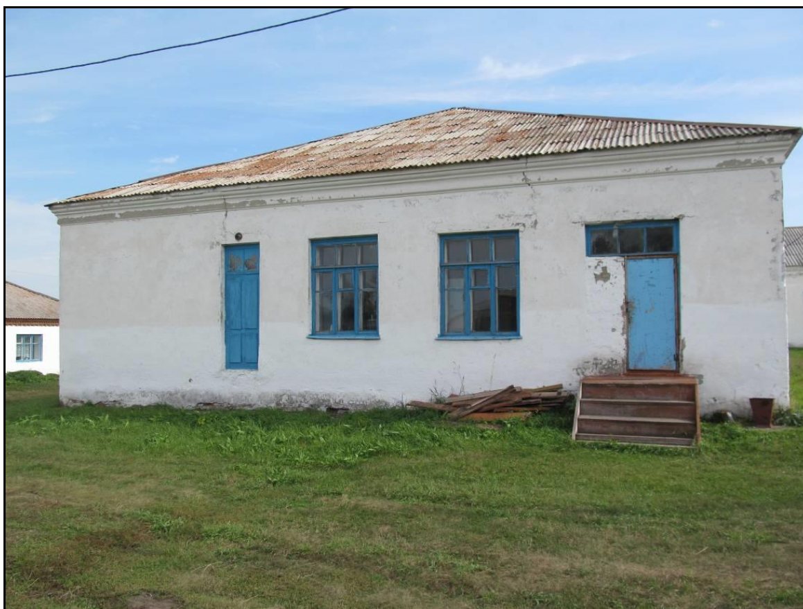
Фрагмент фасада в осях «1-2»
