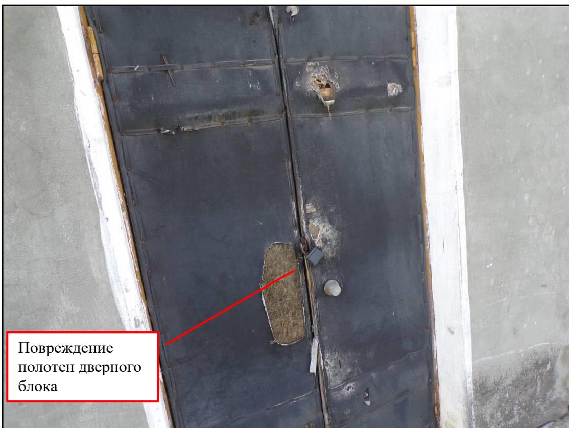
Повреждение полотен дверного блока
