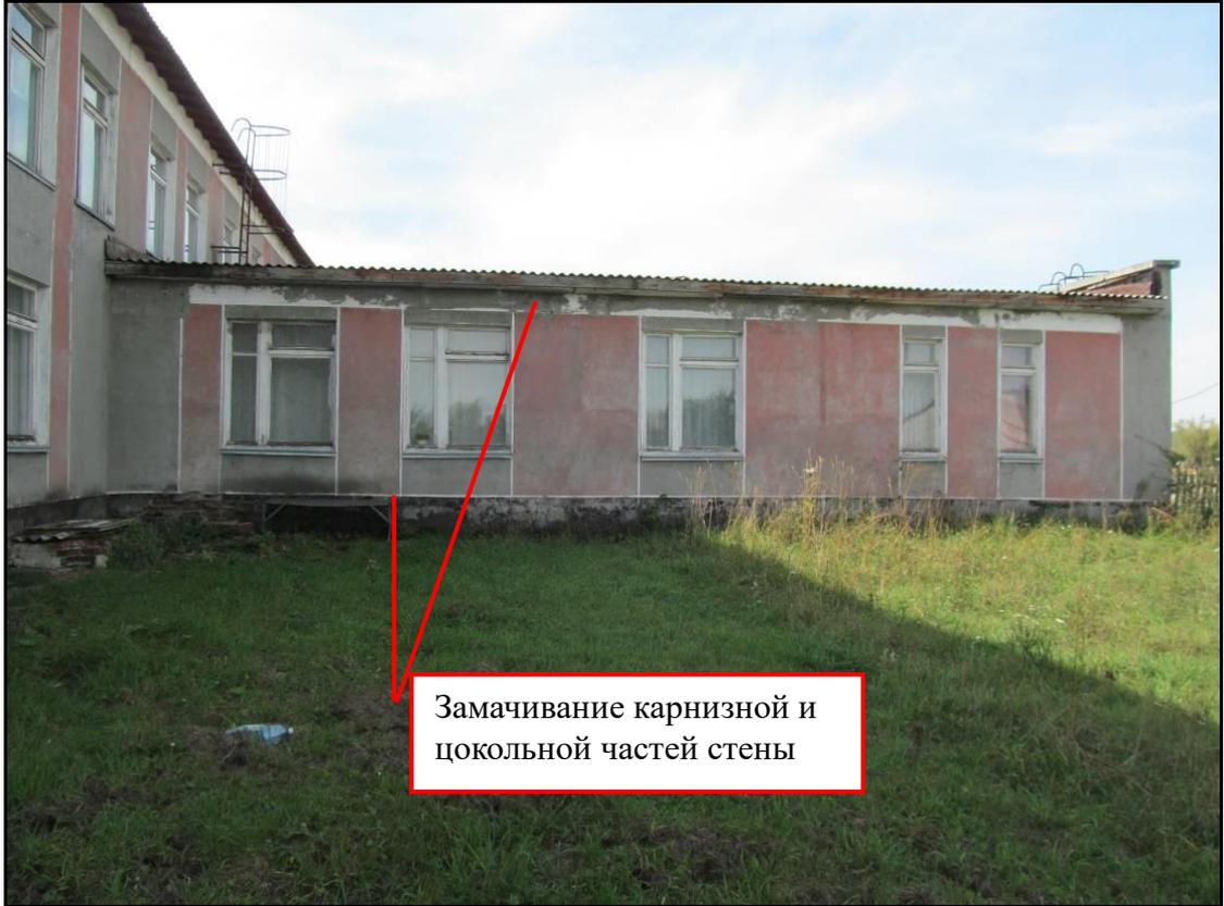
Рис. 5 Фрагмент наружной стены
