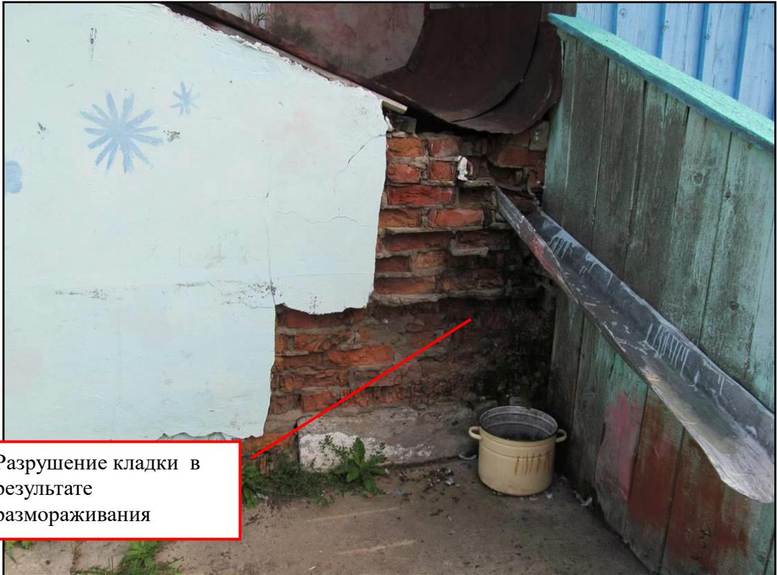
Разрушение кладки в результате размораживания
