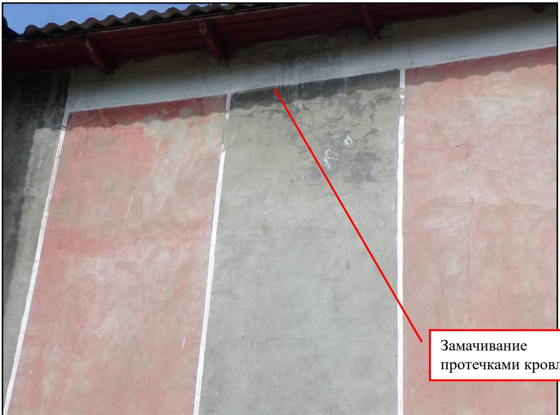
Рис. 4 Фрагмент наружной стены
