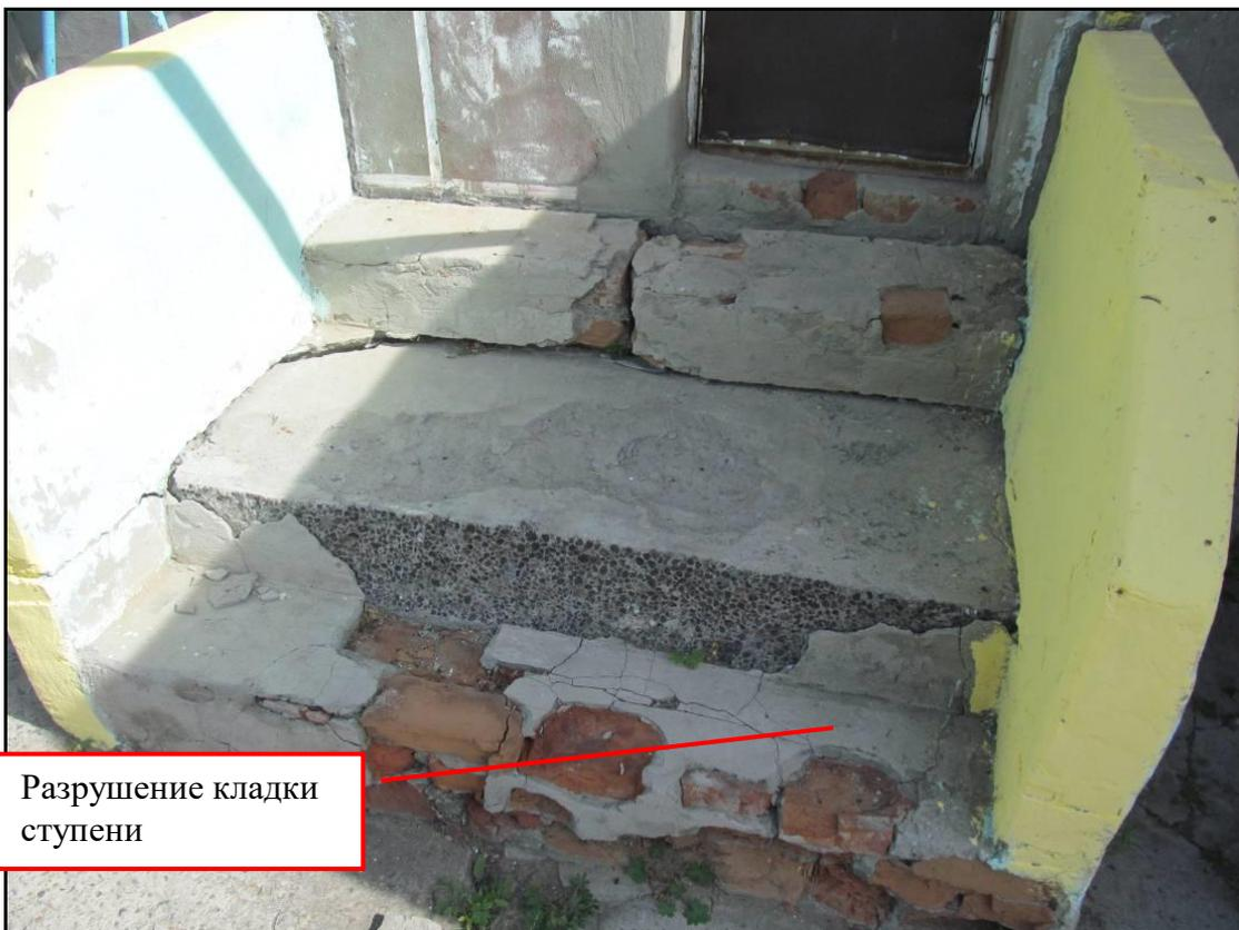
Разрушение кладки ступени
