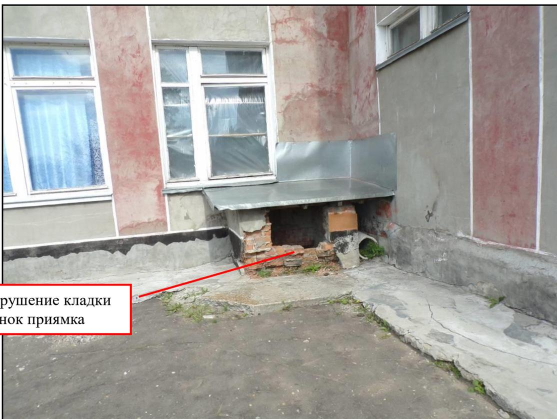
Разрушение кладки стенок приямка
